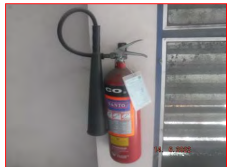
ภาพที่ 2.2-36 ถังดับเพลิงชนิด CO 2 บริเวณโรงคัดแยกเศษอะลูมิเนียม
